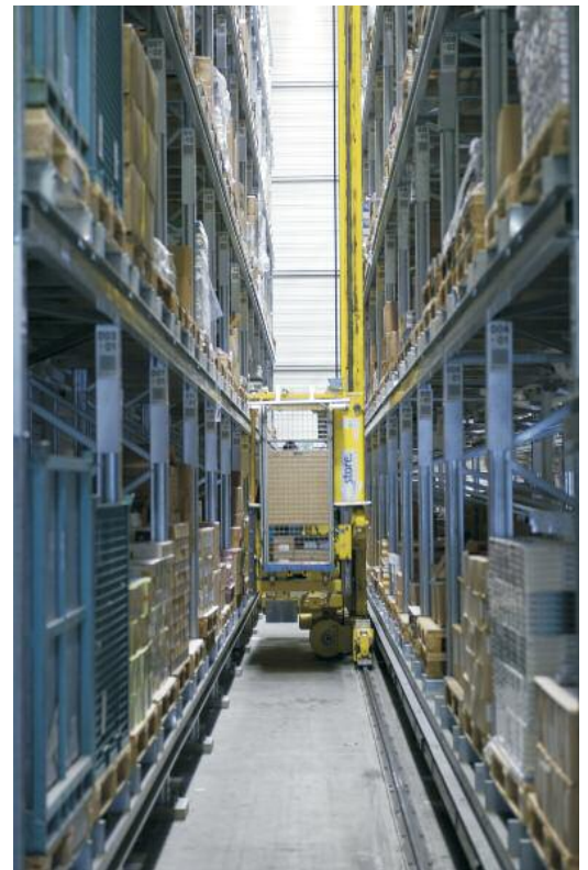
Das Teilmengen-Entnahmehager bietet in 32 Gassen Platz für rund 10 000 Europaletten
