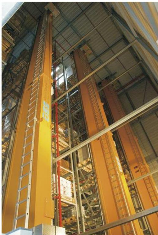
Die Regalanlage im Neubau besteht aus drei Gassen für die einfachtiefe Lagerung von Paletten in 13 Ebenen und wird von drei Regalbediengeräten ver- und entsorgt
