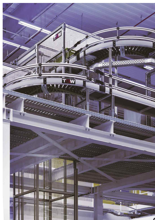
Zwei permanent laufende Vertikalförderer von TGW bringen bis zu 800 Tablare pro Stunde aus der Lagerebene zu den Arbeitsplätzen und zurück
