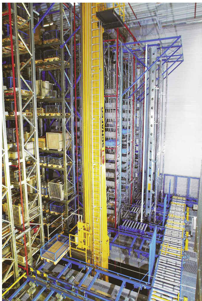
Kombination aus automatischem Hochregalpalettenlager (links) und automatischem Kleinteilelager von SSI Schäfer
