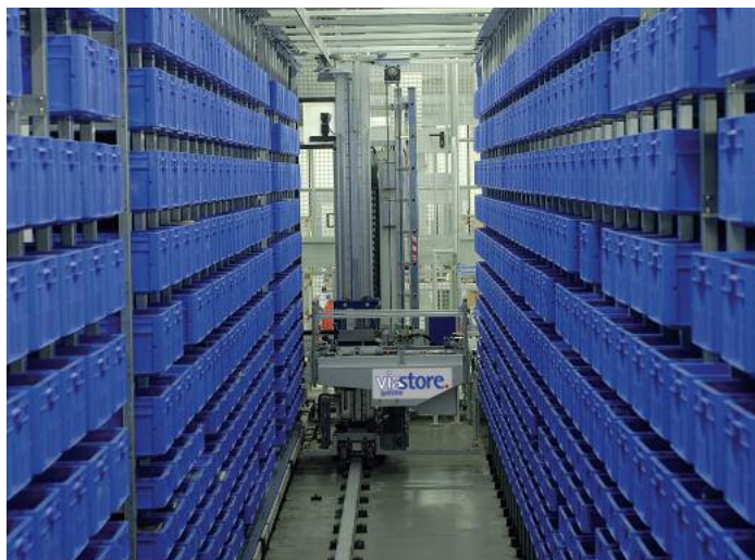
Automatisches Kleinteilelager im Logistikzentrum des Werkzeugmaschinenherstellers Trumpf. Lieferant: Viastore
