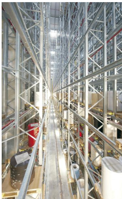
Das Lager ist 24 m hoch, 120 m lang und 16 m breit. Es wird aus SAP WM/TRM gesteuert
