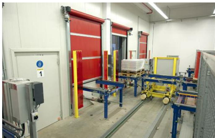
Für die Gassengleichverteilung der Produkte sorgt der Verschiebewagen im automatischen Hochregallager
