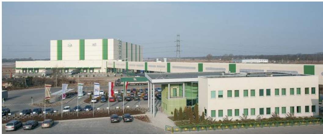
Das automatisierte Logistikzentrum des Hygienepapierherstellers ICT in Polen ist über die neue automatische Förderanlage direkt an die Produktionslinien angebunden
