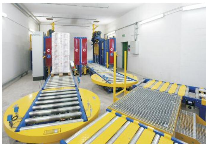
Die Paletten gelangen auf zwei Strecken über eine Förderbrücke in rund 5,5 m Höhe von der Produktion zum Hochregallager
