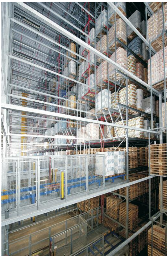
Im 36 m hohen, 9-gassigen automatischen Hochregallager stehen rund 60 000 Palettenstellplätze zur Verfügung
