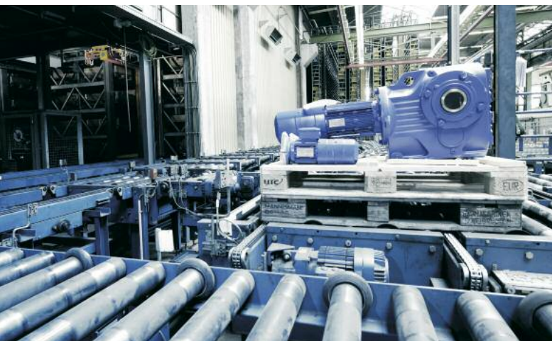
Die neuen Antriebe konnten über die Fördertechnik des zu modernisierenden Lagers in die Gassen gebracht werden
