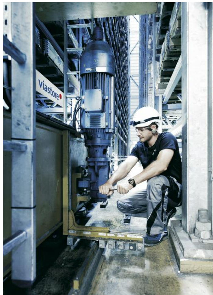
Die schweren Fahrtriebe der Regalbediengeräte mussten innerhalb der engen Regalgassen getauscht werden
