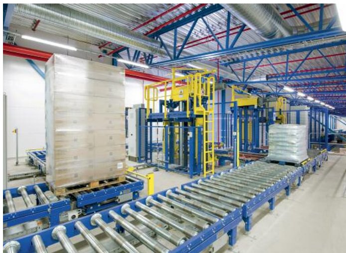
Artikelreine Paletten mit Fertigprodukten und Mischpaletten gelangen über Vertikallifte auf eine Bühnenkonstruktion
