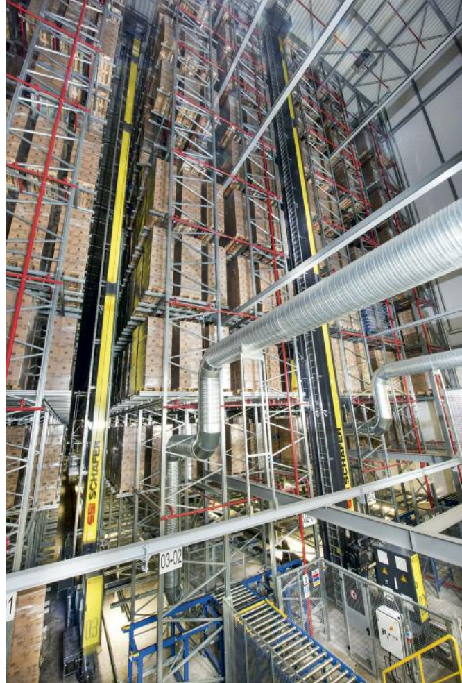
Das fünfgeschossige automatische Hochregallager mit 19 100 Stellplätzen wurde von SSI Schäfer installiert
