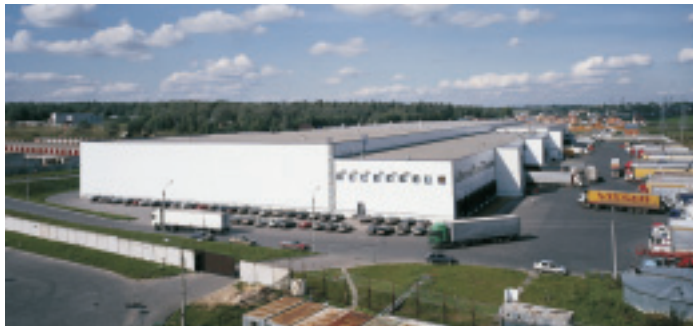
Der russische Logistikdienstleister National Logistic Company (NLC) betreibt das Logistikzentrum als Kontraktlogistiker
