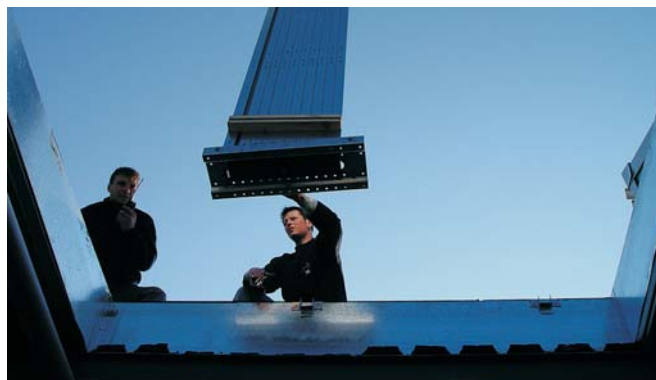
Beim Umbau des automatische Kleinteilelagers von Pistor war wegen enger Platzverhältnisse Millimeterarbeit gefragt
