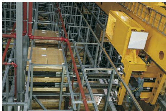
Die Regalbediengeräte setzen die Ladeinheiten auf dem hinteren oder vorderen Regalplatz im Lagerfach ab
