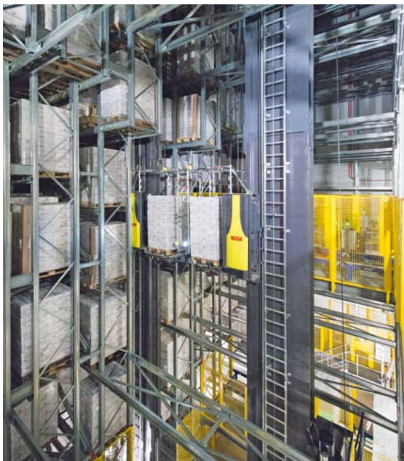
Zum Einsatz bei La Lorraine kommen fünf Zwei-Mast-Regalbediengeräte vom Typ Exyz, die in ihren Komponenten speziell auf den Betrieb im Tiefkühlbereich ausgelegt wurden.
