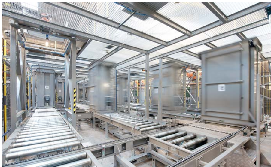
Die metallischen Palettenstapelhilfen laufen auf einer doppelbahnigen, separaten Förderstrecke unterhalb der Roboterarme
