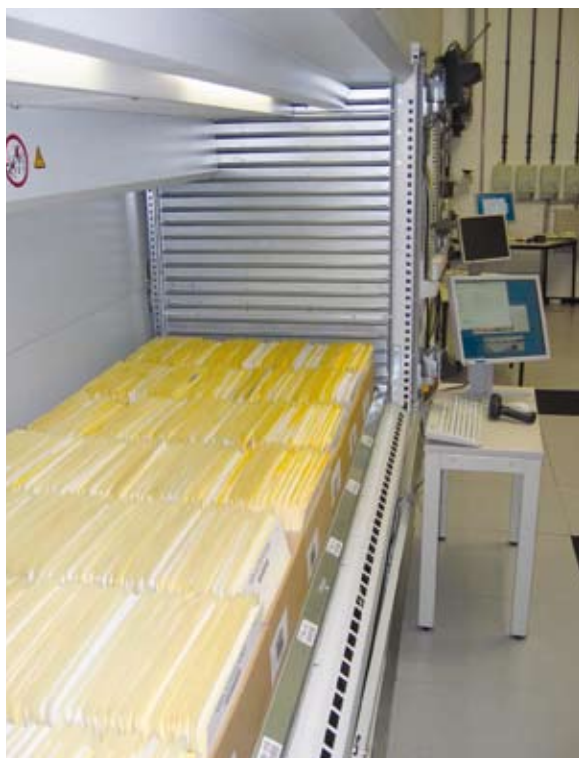
Nachdem sich der autorisierte Lagermitarbeiter am Shuttle angemeldet hat, werden nur die Tableaus mit Mappen ausgelagert, für die ein Auftrag vorliegt.
