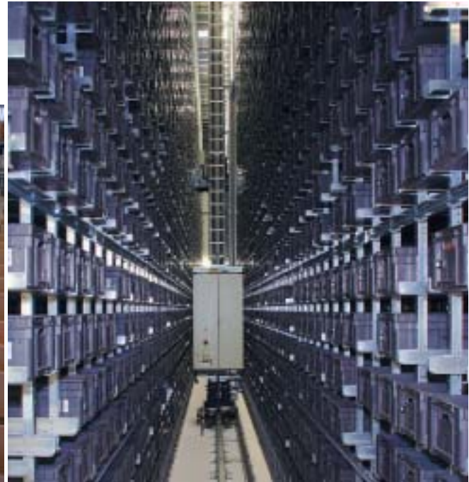
Endlich Platz: Das neue automatische Kleinteilelager bei Weidmüller schaffte 80.000 Lagerstellen.
