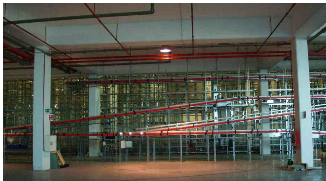
Blick auf die Fördertechnik zur Versorgung der Mercury-Module
