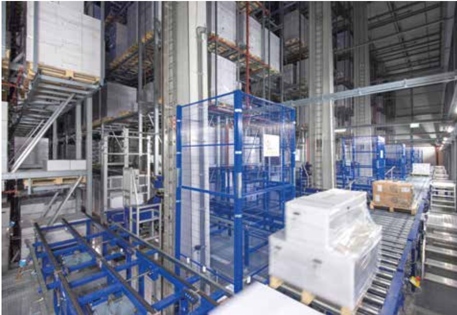
01 Sechsgassige Regalanlage für 17 240 Paletten
