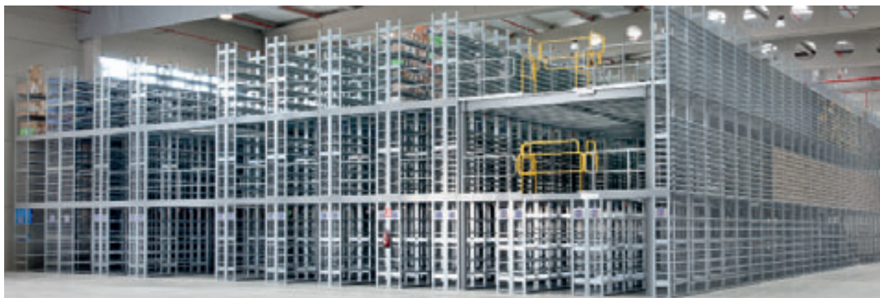
Die 3-geschossige Fachbodenregalanlage bietet über 2.400 m 2 Platz für eine moderne Lagerung und Kommissionierung der Zulieferteile
