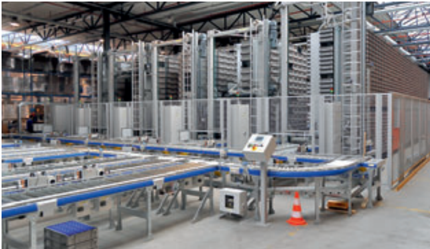
Die SCS-Anlage umfasst 5 Karusselle mit je 80 Trägern
