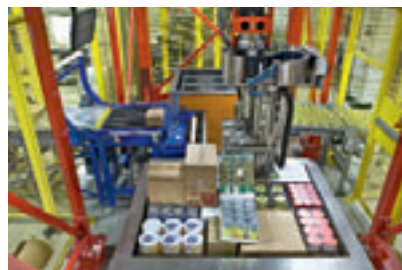
Das SCP-System ist auf einen Durchsatz von bis zu 74 Paletten pro Stunde mit 5.350 Cases ausgelegt
