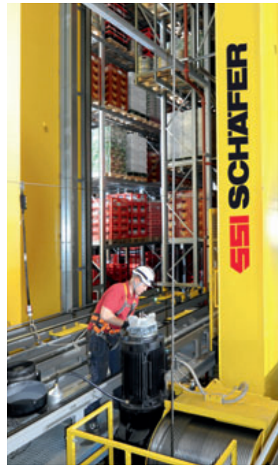
SSI Resident Maintenance – Service nach Wunsch
