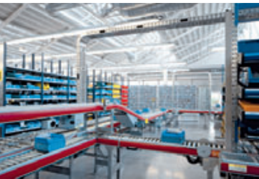
SSI Schäfer installierte Fördertechnik mit neun Stichbahnen
