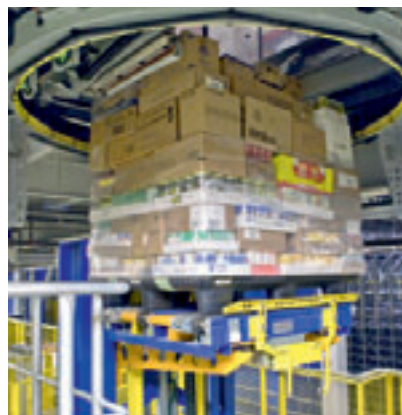
Die gefüllten Paletten werden auf die Warenausgangsebene abgesenkt und automatisch von einem integrierten Folien-Stretcher umwickelt
