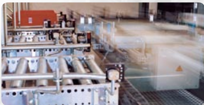
Förderstraße eines COGLAS® verwalteten AKL
