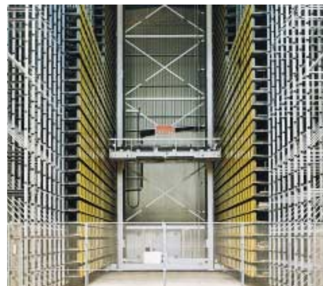
Automatisches Wabenlager bis 25 m Höhe "Ware zum Mann"
