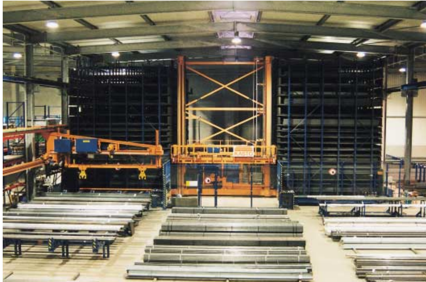
KASTO Wabenlager UNICOMPACT mit zwei Auslagerstationen, Kommissioniergerät und Ablagepolder.
