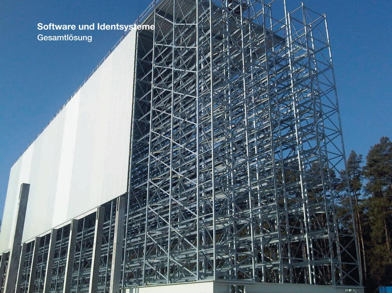
Das neue Hochregallager hat eine Höhe von 28 Metern und wird in Silo-Bauweise errichtet – hier ist die Fassade noch nicht fertig.
