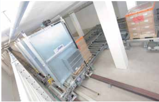
Bild 2: Auch die fördertechnische Ausrüstung des 120 m langen Tunnels, der Hochregallager und Versandgebäude miteinander verbindet, wurde von viastore realisiert
