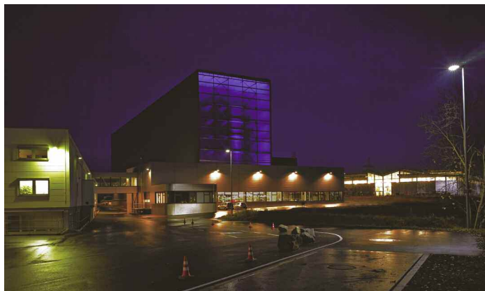
Die von innen futuristisch beleuchtete Stirnseite des Hochregallagers zeugt von der Modernität der Anlagentechnik
