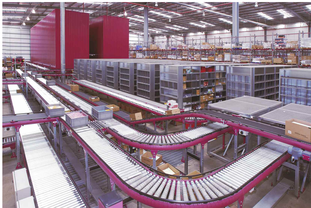
Die automatische Rollenfördertechnik für Behälter und Kartons bei Office Depot macht den manuellen Eingriff beim Materialtransport überflüssig. Im Hintergrund der Commissioner
