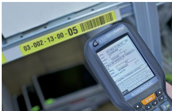
Durch den Ausbau der WLAN-Struktur greifen die Mitarbeiter auf alle Informationen online per Handheld-Computer zurück
