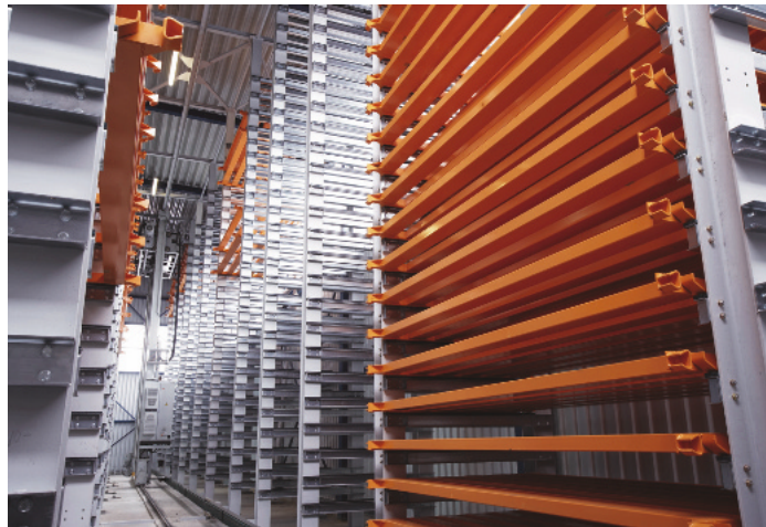
Uniline-Blechlagersystem mit geführtem Regalbediengerät, Stahlbau für zwei Palettengrößen und drei Beladehöhen
