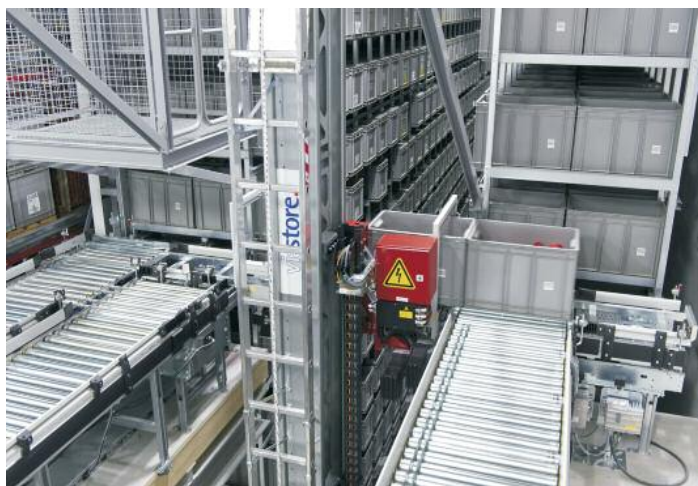
Die doppelt tiefe Lagerung im AKL erforderte Anpassungen in SAP EWM durch die Software-Experten von Viastore
