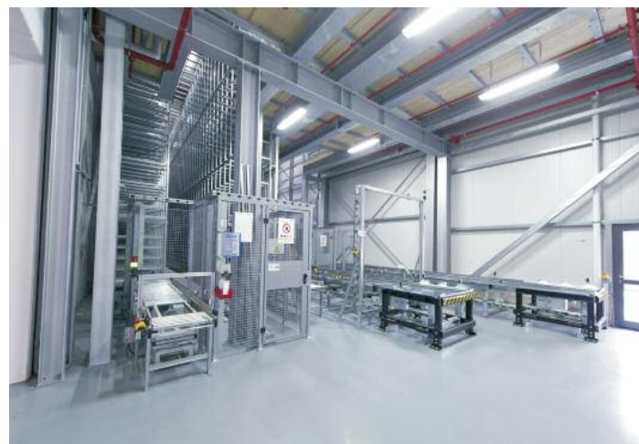
Die Kunststoffspritzerei hat, wie die Blechfertigung, eine Ein- und -Auslagerzone für das Kleinteile- und Palettenlager
