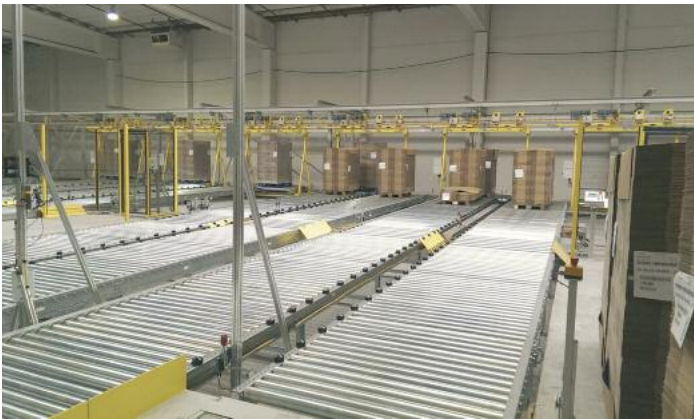
Jeder Verladezone sind vier Förderbahnen zugeordnet, über die die Paletten zur schnellstmöglichen Verladung heranrollen
