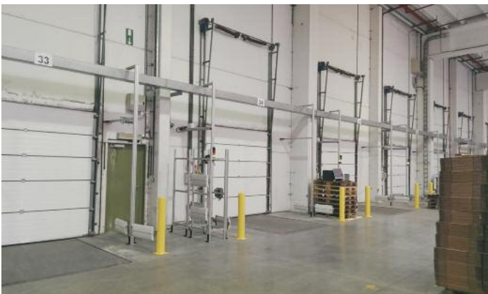
Die Verladetore sind mit RFID-Gates ausgerüstet. Damit werden die Paletten und Waren eindeutig dokumentiert
