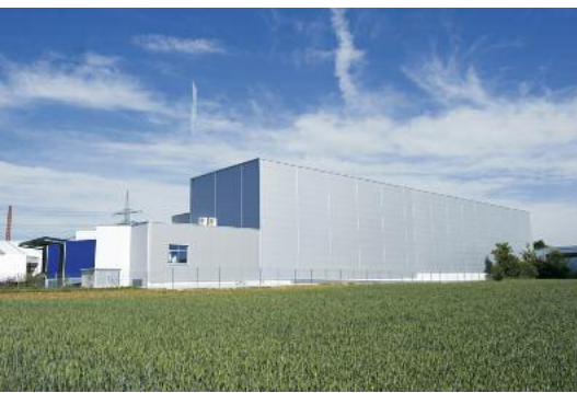
Das Orochemie-Hochregallager ist nach der Erweiterung 72 m lang
