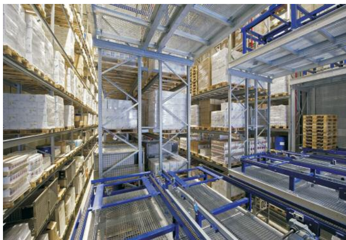
Die Einlagerung sämtlicher Waren erfolgt auf der unteren Ebene, die Auslagerung der Rohwaren eine Ebene darüber
