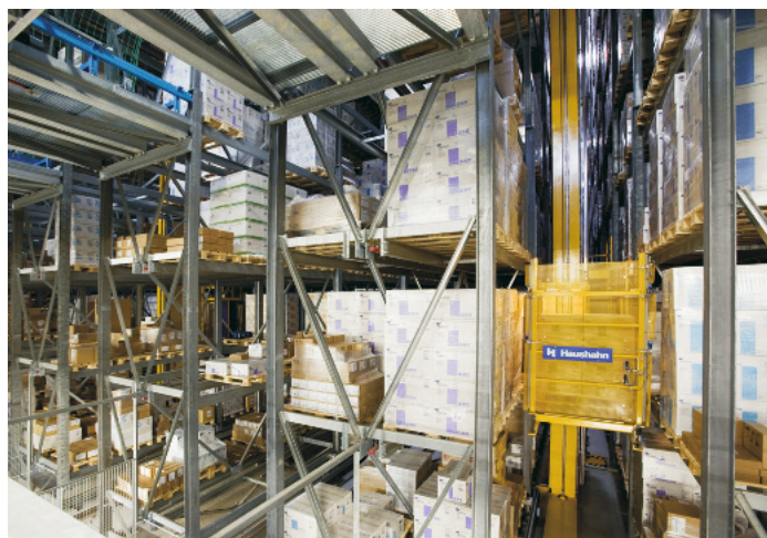
Lifetime-Partnership: Die automatischen Regalbediengeräte im älteren Teil tragen noch den Namen Haushahn
