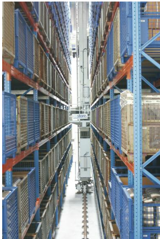
Das eingassige Palettenlager bietet mit doppelttiefer Lagerung Platz für 1 268 Gitterboxpaletten
