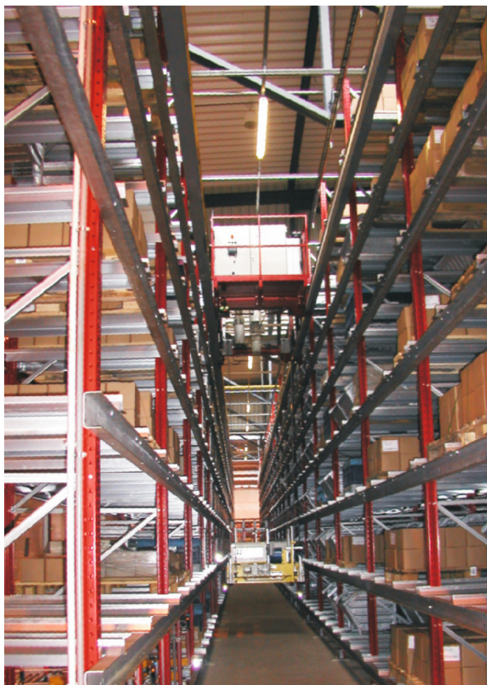
Die an einer Verfahrenseinheit an Stahlseilen hängende Transfaster-Einheit mit Lastaufnahmemittel beim Einlagervorgang
