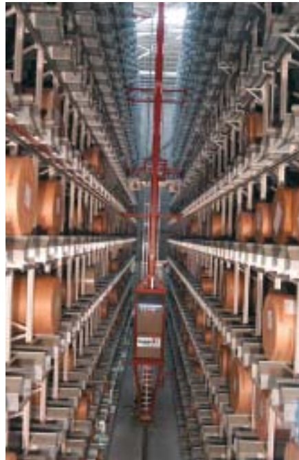
Zwei Regalfahrzeuge bedienen mit dem Satellit für Rollenhandling insgesamt 7 200 Papierrollen in drei Lagerblöcken
