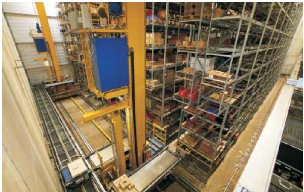
Blick in das automatische Hochregalpalettenlager von Microlog mit zwei Umsetzbrücken und zwei Regalbediengeräten für insgesamt sieben Regalgassen
