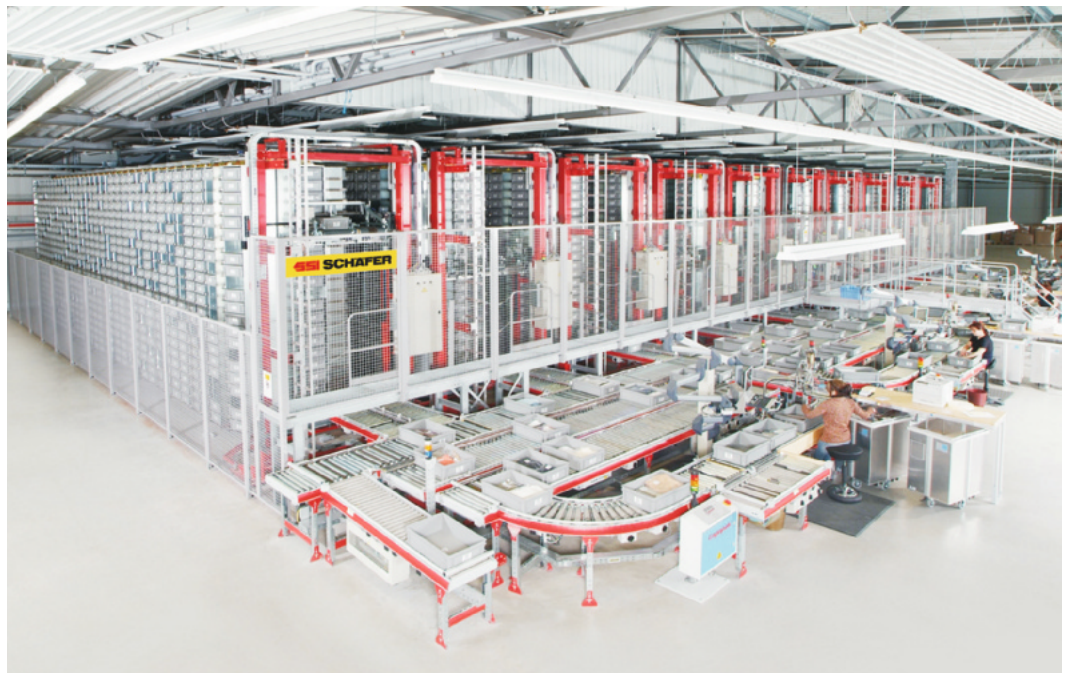
Beim Versandhandelsunternehmen Witt, Weiden, hat SSI Schäfer, Giebelstadt, das Kommissionier- und Retourenlager zum Jahresende 2006 als Generalunternehmer fertiggestellt
