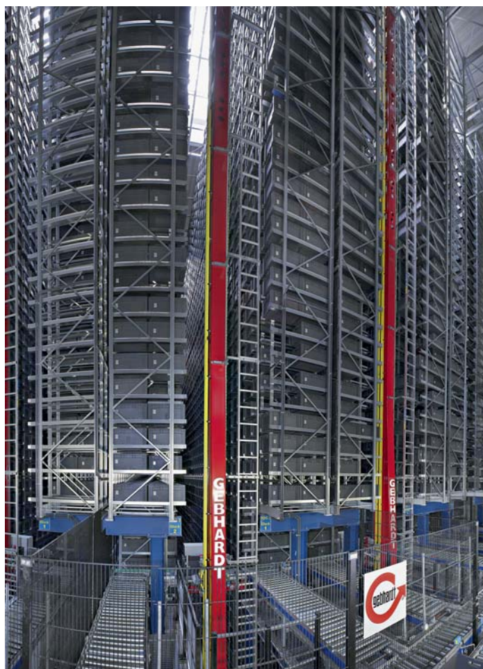
Über 21 m hohes automatisches Kleinteilelager von Gebhardt Fördertechnik bei der Hans Werner GmbH & Co. KG
