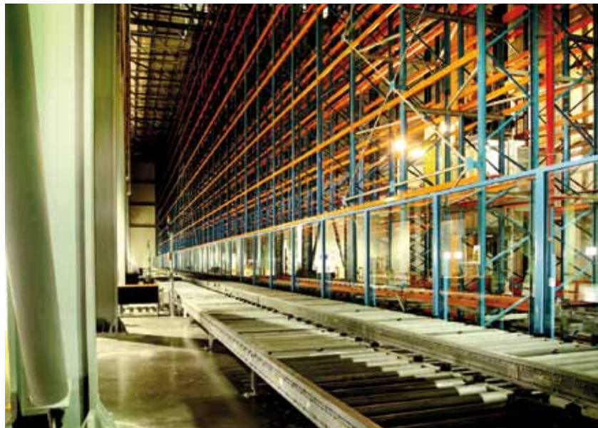
Vor allem Sensorik, Antrieb und Lastaufnahmemittel der Regalbediengeräte müssen so angepasst werden, dass sie der Kälte dauerhaft standhalten.
