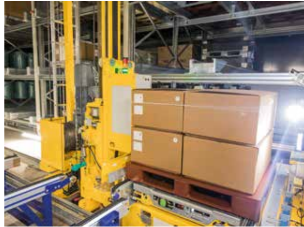
Das im Einsatz befindliche Powershuttle benötigt keine Kabelverbindung, sondern kommuniziert per Funk mit dem RBG.
