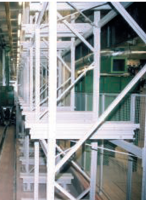
1 Im Tageslager des Druckzentrums Südwest können 213 Papierrollen in 3 bzw. 4 Ebenen gelagert werden. Das automatische Regalfahrzeug mit Teleskopgabel transportiert bis zu 1500 kg schwere Papierrollen
