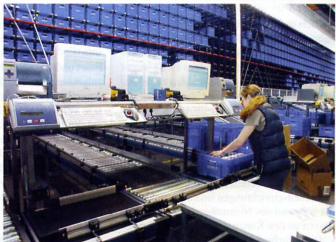
3 Nahezu ohne Wartezeiten werden aus dem überlangen AKL A-, B- und C-Teile kommissioniert
