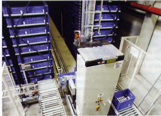
④ Mit Kombi-Teleskop-Lastaufnahmemittel und doppelt tiefer Behälterlagerung wurde der Fahrzeitanteil pro Lagerspiel reduziert
