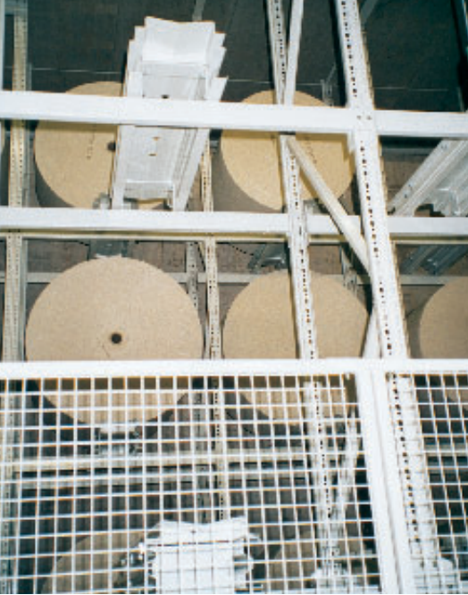
Bild 2 Im Tageslager können in zwei Lagerblöcken 213 Papierrollen in zwei bzw. drei Ebenen vom RFZ eingelagert werden.
