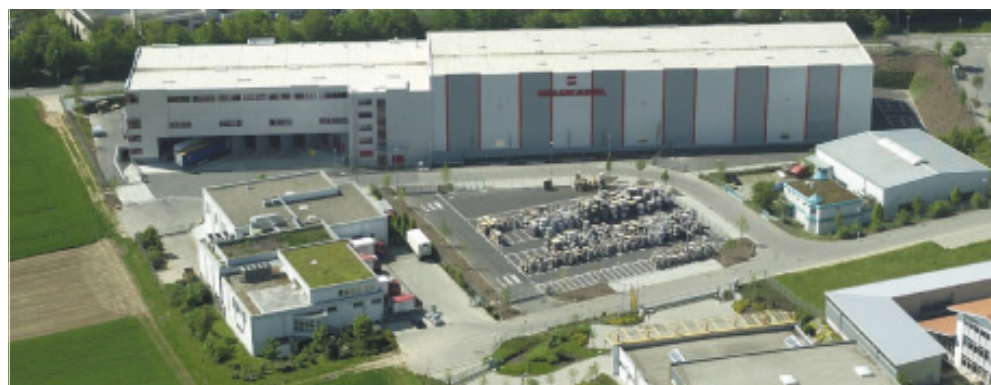
Bild 4 Luftaufnahme des Logistikzentrums der Helukabel GmbH.
