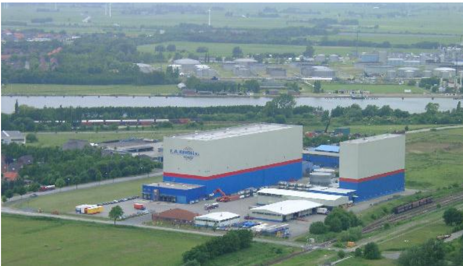
Bild 1 Rund-um-die-Uhr-Service aus gewaltigen Hochregallagern – daher mussten bei der Spedition Kruse auch das WMS und der MFR bei laufendem Betrieb modernisiert werden.
