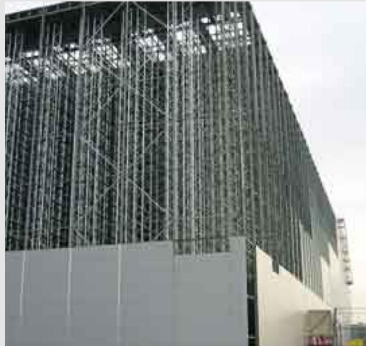
Nach der Fertigstellung des Stahlbaus wird die Wandverkleidung hochgezogen.
