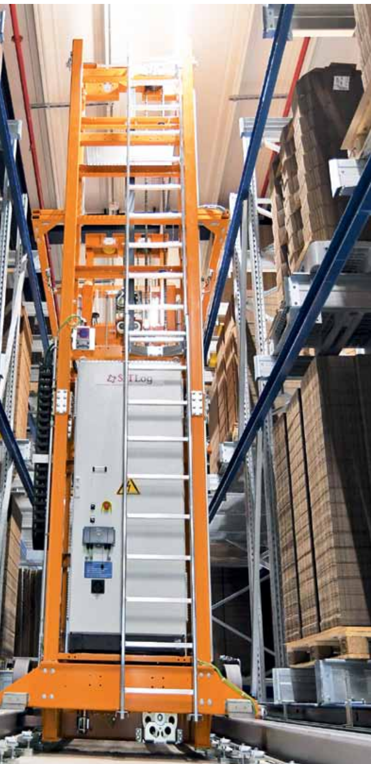
Regalfahrzeug im Satellitenlager mit 800 Stellplätzen, für das bis zu 2.200 Millimeter hohe und 1.800 Millimeter breite Ladegut.
