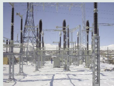
Arbeiten auch bei minus 30 °C an der 220 KV-Schaltanlage in Kamo
