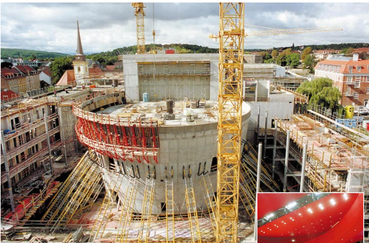
Richtfest am 5. September 2001 – schon im Rohbau eindrucksvoll
