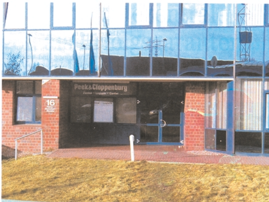
3: Das Zentrallager vor den Toren Hamburgs
