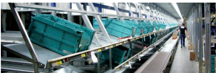
Im AKL erfolgt die Bereitstellung der Waren je nach aktuellem Bedarf dynamisch.
