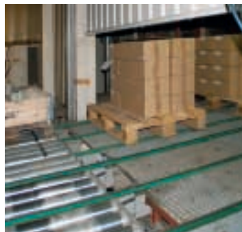
Den zeitkritischen Umbau hat viastore reibungslos durchgeführt.
